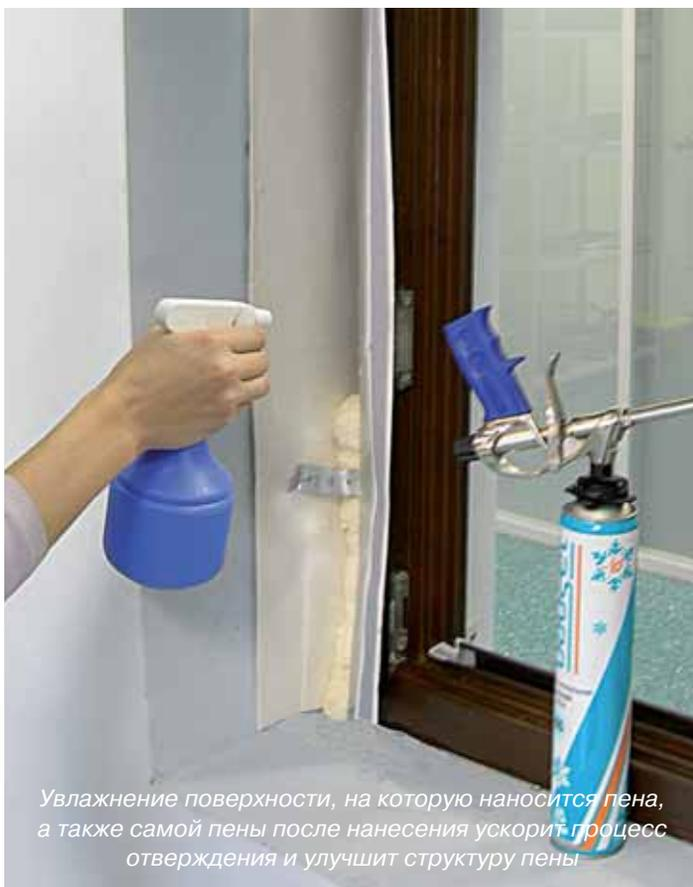
*Увлажнение поверхности, на которую наносится пена, а также самой пены после нанесения ускорит процесс отверждения и улучшит структуру пены*
