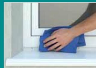
**4.** При помощи салфетки протереть и обезжирить поверхность, на которую будет производиться монтаж.
