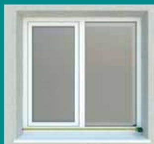
**1.** В начале работ произвести замер монтажного шва и определить ширину для выбора вида нащельника и длину для определения количества материала.
