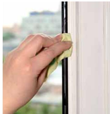
пятствует его старению. Средства для ухода за уплотнителями выпускаются в различных вариантах: в виде спрея, в виде карандаша, в пластиковой тубе или в виде эмульсии во флаконе с дозатором. Из всего вышеперечисленного наиболее удобна для применения эмульсия, так как на салфетку можно нанести точную дозу и полностью протереть уплотнитель, включая труднодоступные места.
