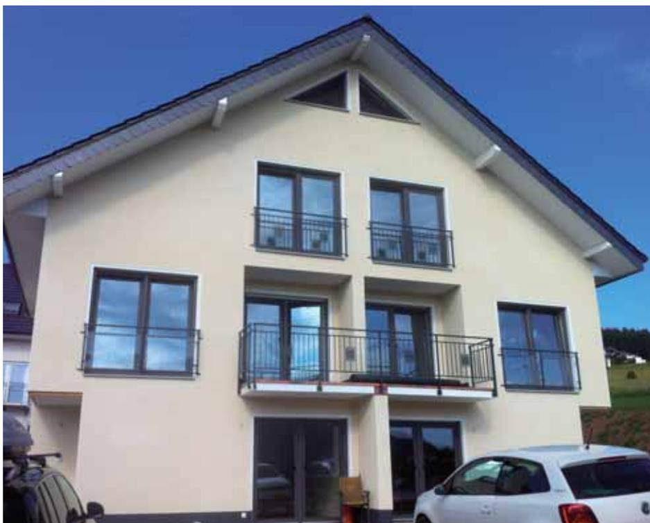
ции рамы и, как следствие, последующей разгерметизации оконной системы. Решением этой проблемы являются специально разработанные пигменты, используемые при производстве ПВХ-основы для пленки.
