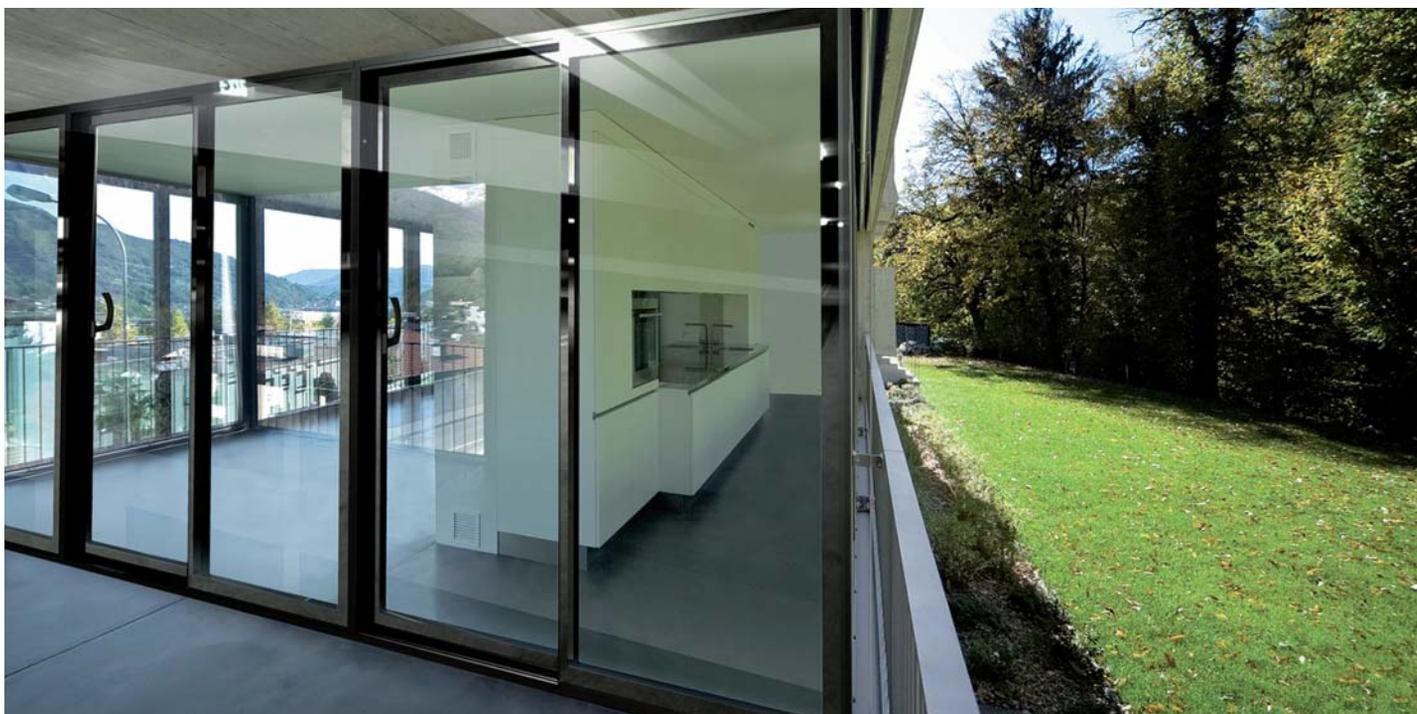
*Пример габаритного остекления: подъемно-раздвижные конструкции ALT SL160 от ГК «АЛЮТЕХ». Вес створок может достигать 400 кг.*
