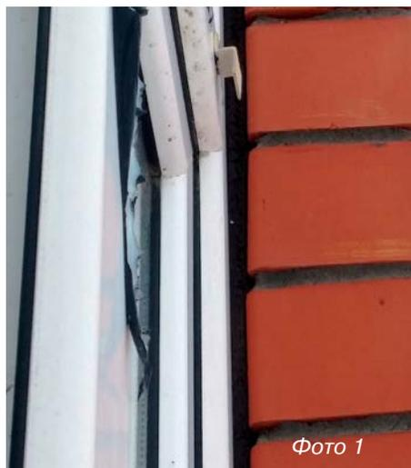
Фото 1. Внешний вид монтажного шва окна, на которое жаловался потребитель, до нанесения герметика Стиз А.
