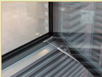
Нередки случаи, когда распахиваемое сквозняком окно вызывает захлопывание входных дверей и падение стоящих на подоконнике предметов. Бесконтрольно открывающиеся оконные створки могут нанести большой урон. Устранить этот недостаток поможет специальный элемент, который устанавливается на окно – ограничитель открывания. Этот механизм защитит мебель, стены, а также саму створку окна от повреждений.
