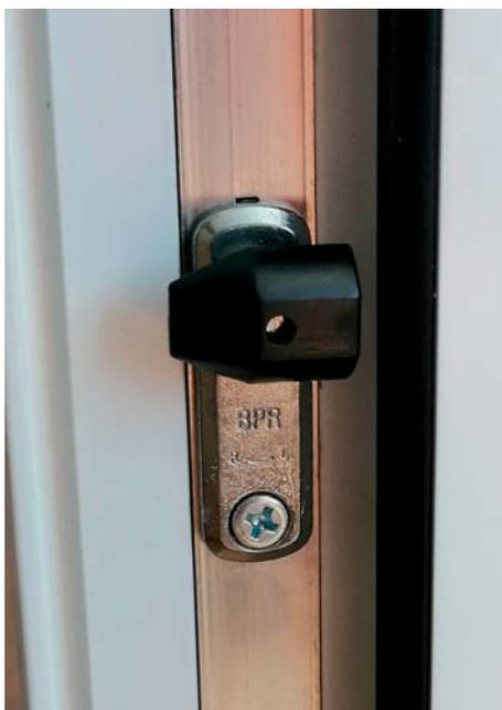
многоступенчатого проветривания. Ступенчатое или пошаговое проветривание дает возможность зафиксировать положение створки в четырех разных положениях откидывания, меняя таким образом интенсивность проветривания.
