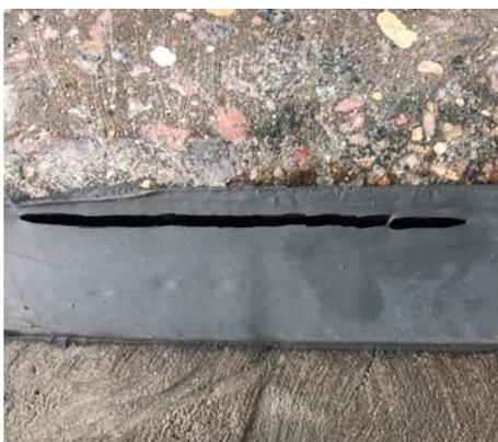
Рис. 1. Фотография «плоского» шва между бетонными плитами. Возник разрыв герметика у одной из стенок шва
